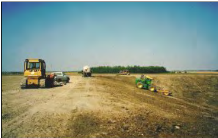
Conservation Manitoba édicte des normes strictes pour la construction des structures d'entreposage du fumier
